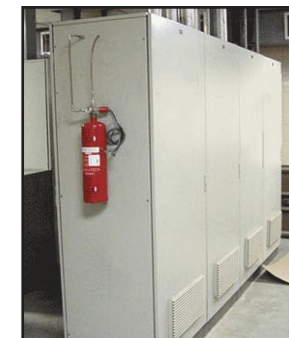
Пример внешнего монтажа АУП-01Ф-03
